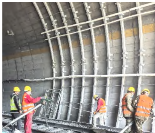
图 10 钢拱架加固法现场图
