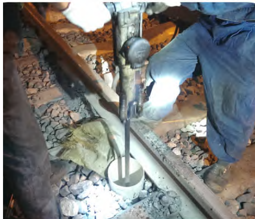
图 9 钻孔注浆法现场图
