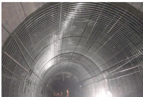
图 11 波纹板加固法现场图
