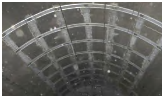
图 12 W 钢带加固法现场图
