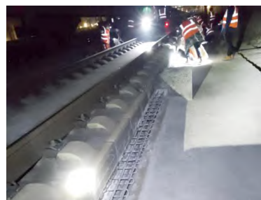
图 9 底座板局部凿除重筑
