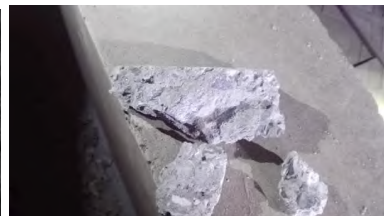
(b)内部混凝土状态
